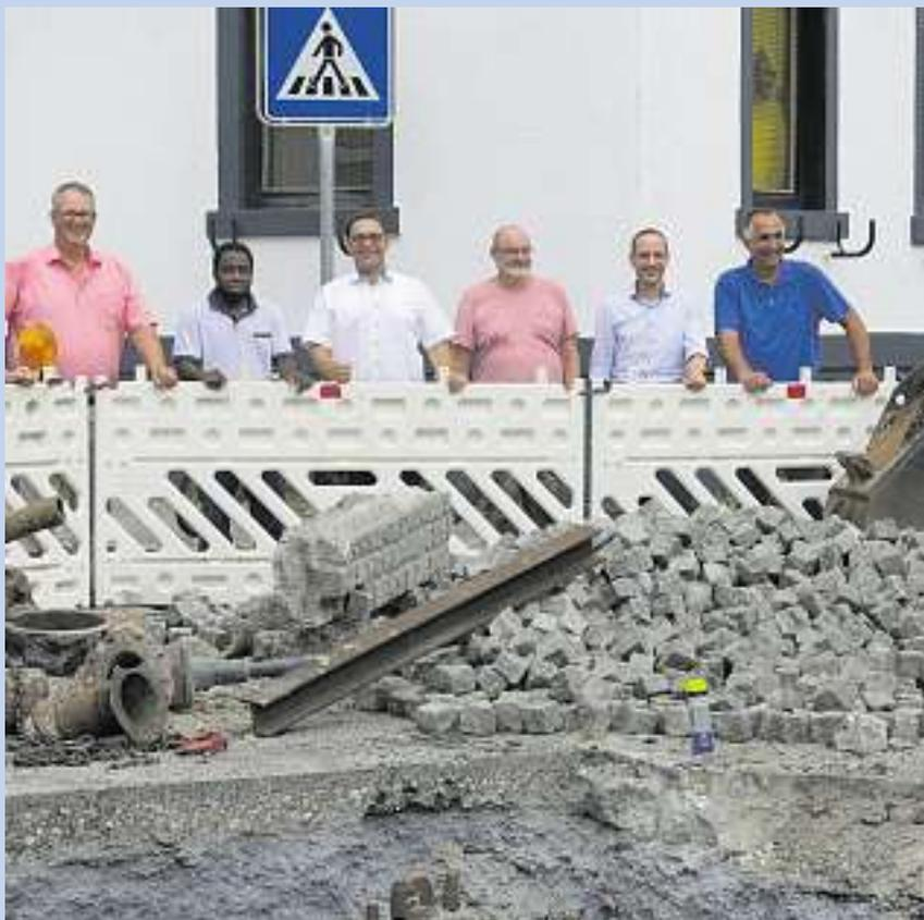
Nach Fertigstellung der derzeit aufgenommenen Arbeiten in der Kreuzung Römerstraße und die Muhrfeldstraße um. Dort wird der zu kleine Regenwasserkanal durch einen größeren Kanal auf einer Länge von ca. 200 Meter ersetzt. Aufgrund der geringen Tiefe müssen für die Vergrößerung des Fließquerschnittes besondere Rahmenprofile mit Kantenlängen bis zu 1200 mm x 600 mm eingesetzt werden.
