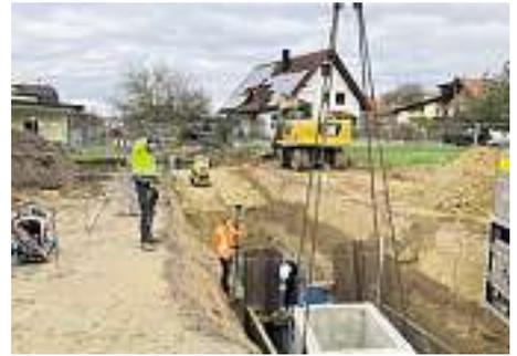
monolithischen Schachtbauwerke der Kanalisation müssen dabei teilweise mit dem Schwerlastkran versetzt werden. Trotz teils ergiebiger Niederschläge konnten die Kanalisationsarbeiten auch in den letzten Wochen weiter vorangetrieben werden.
