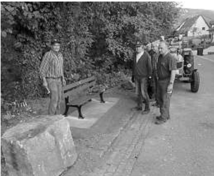
Ein strahlender 2. Vorsitzender Reinhold Winzer mit seinen Mannen nach Abschluss der Arbeiten
