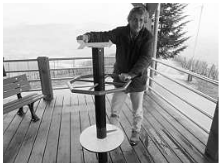
Klaus Schmidt bei der Montage des reparierten Richtungsanzeigers
