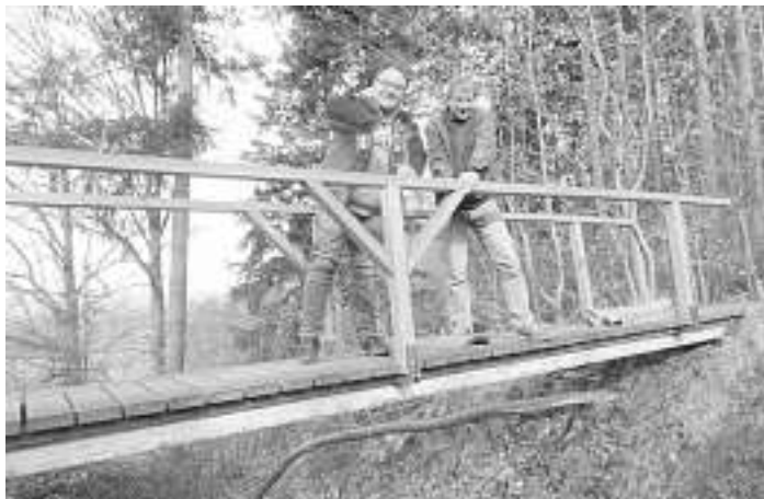
Bernhard Keller und Klaus Schmidt bei der Brückenmontage
