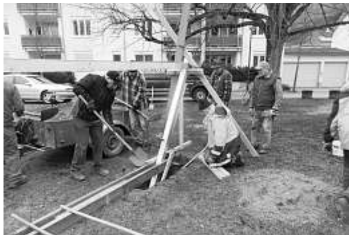
Das Arbeitsteam beim Einbetonieren der Stützen
