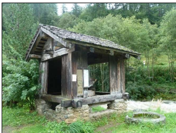
Abb. 4: Gebäude einer alten Hanfreibe in Binn.
